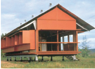
Großer Dachüberstand Glenn Murcutt MariKa-Alderfont-Haus Australien 1994
